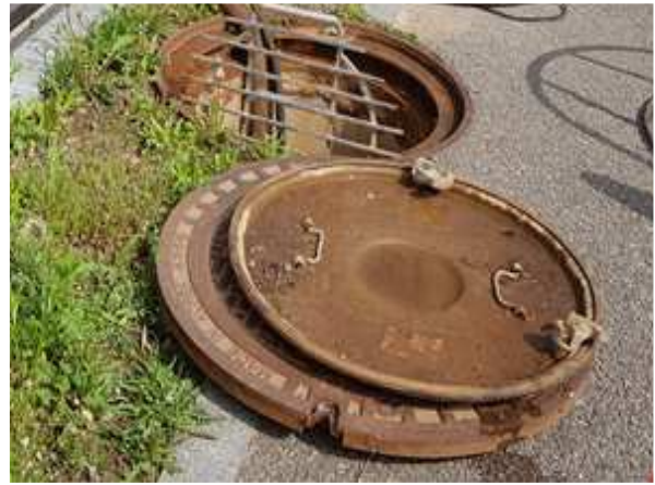
내용 맨홀 내,외부 뚜껑 상태양호
